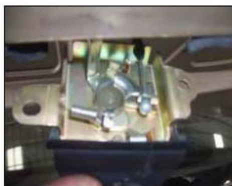
行李舱盖上锁体内部损坏
