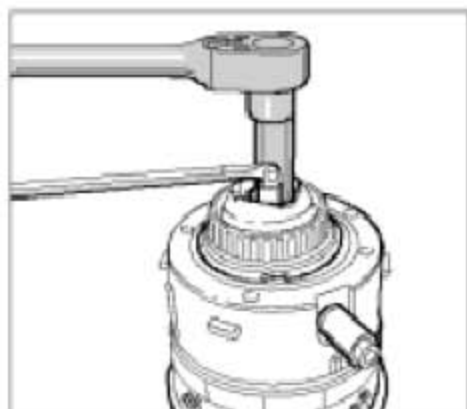
拆卸/安装减震器支座
