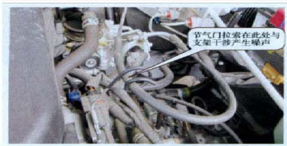
图 1 节气门拉索与支架发生运动干涉
