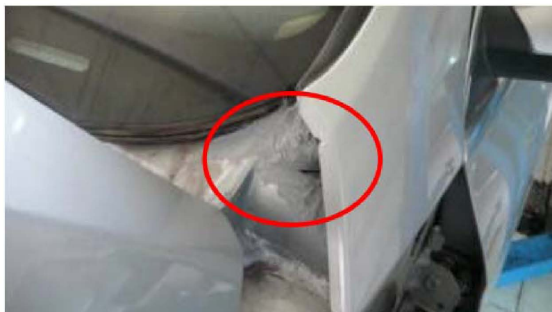
图 3 对该处进行打胶处理
