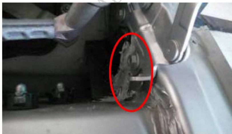
图 4 对该处进行打胶处理
