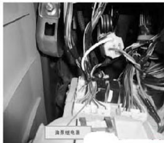
图6 油泵继电器在接线盒中的位置
