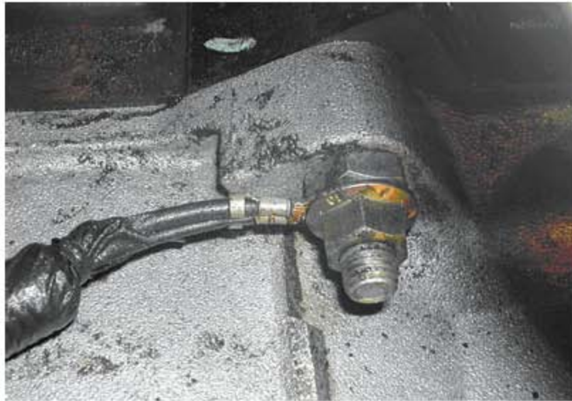
图 2 变速器壳体搭铁点 G117/113 虚接
